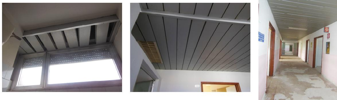
Gli infissi, oltremodo datati, sono in alluminio con soglie in marmo, non a taglio termico, con vetro singolo (tipo float), non di sicurezza e che non garantisce un buon isolamento termico dei locali. Tutte le finestre esterne sono dotate di serranda avvolgibile in alluminio (*vedi blocco foto 5*).
